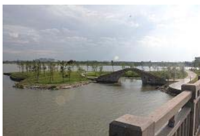
宛山湖湿地公园工程
