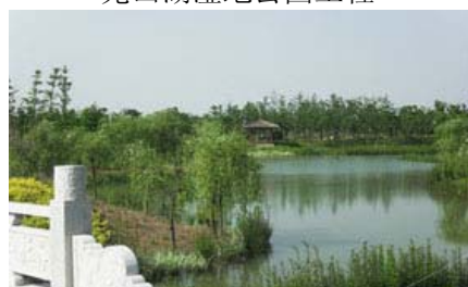
环太湖生态景观林带建设工程
