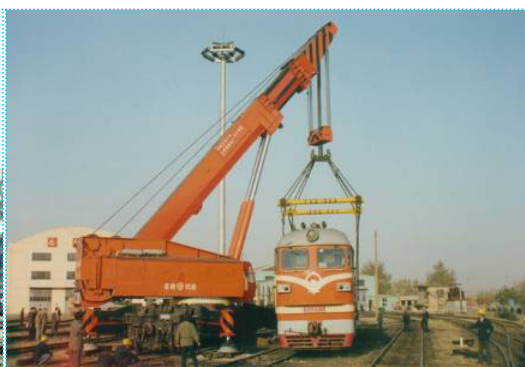
160t伸缩臂式铁路起重机救援中
