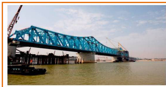
东新赣江特大桥施工中
