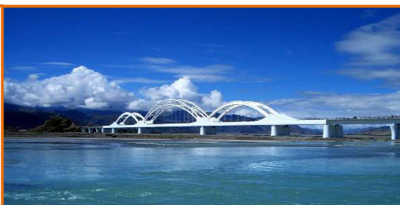
青藏铁路拉萨河特大桥
