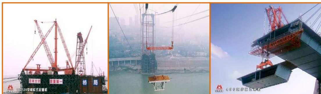
120t桅杆式起重机在天 兴洲大桥施工中
