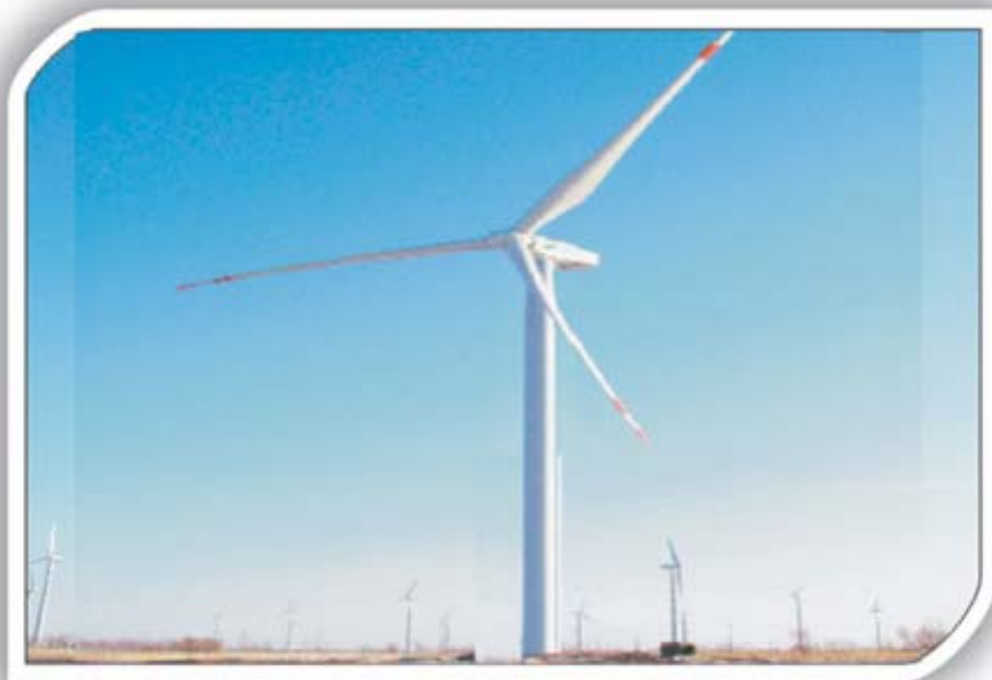
内蒙古通辽风电项目
