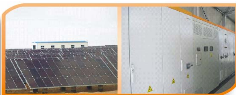
青海格尔木光伏并网电站
