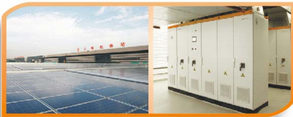
上海虹桥枢纽6.68兆瓦光伏发电项目
