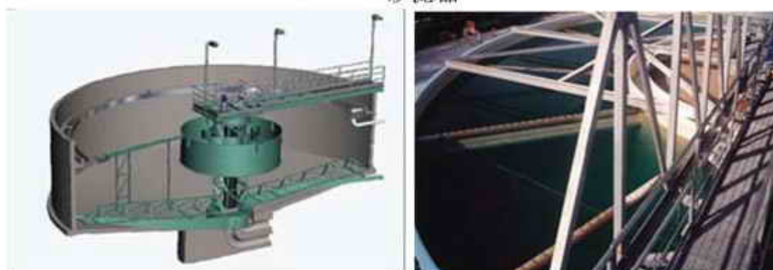
机械搅拌澄清池
