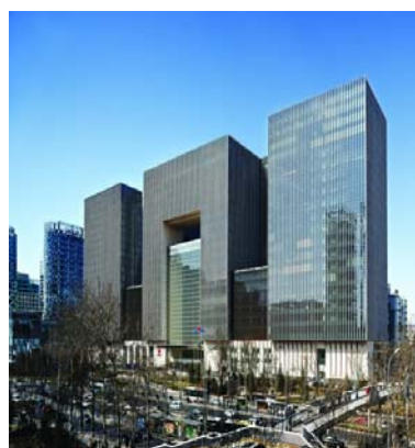
中石油大厦——智能呼吸式内循环幕墙
