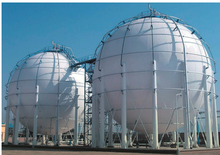
中国最大的两台 4,000 立方米液态烃球罐应用在中国石油兰州石化分公司
