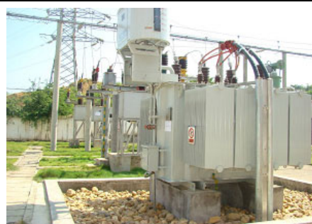
35kV 油浸式变压器 应用于大庆油田、长庆油田
