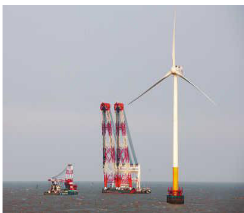
东海大桥海上风电场
