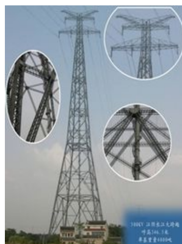
500KV 江阴长江大跨越角钢塔
