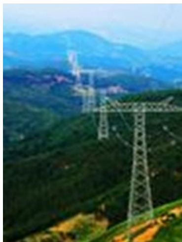
800KV 向上线直线角钢塔
