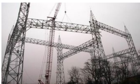
顺德变电构支架
