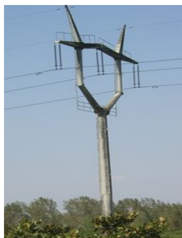
220KV 杯型单柱钢管塔
