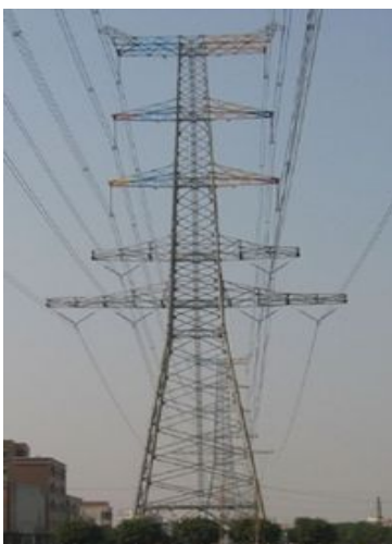
500KV 同塔四回钢管组合直线塔
