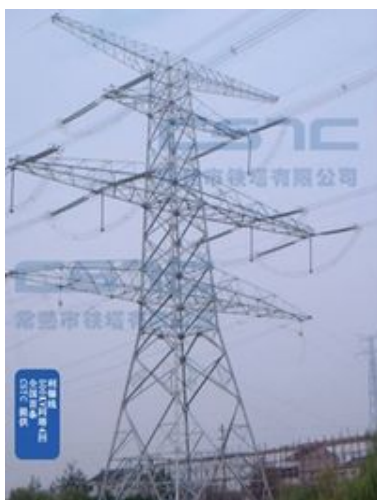
500KV 同塔四回路直线角钢塔
