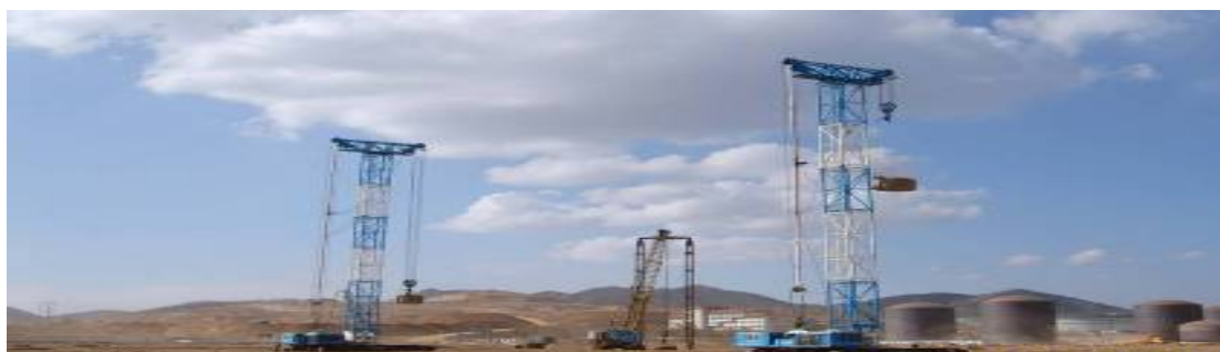
发行人采用强夯地基处理的中化格力珠海南迳湾化工品仓储项目
