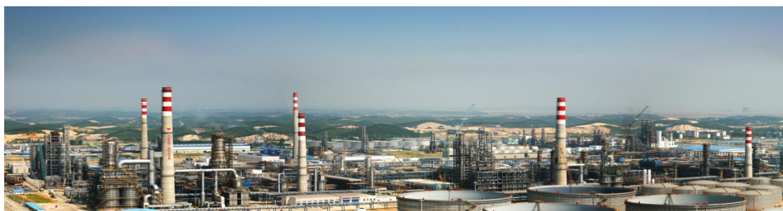
发行人采用强夯地基处理的中石油广西钦州 1000 万吨炼油项目
