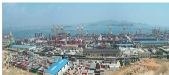
发行人采用强夯地基处理建设的大连新港码头泊位项目
