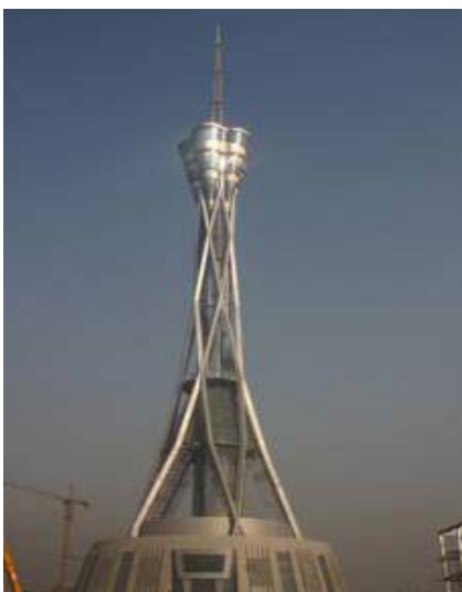
河南广播电视发射塔钢结构工程
