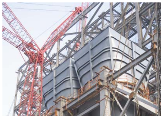
浙江三门核电一期 AP1000 核电机组 常规岛循环泵房钢结构工程
