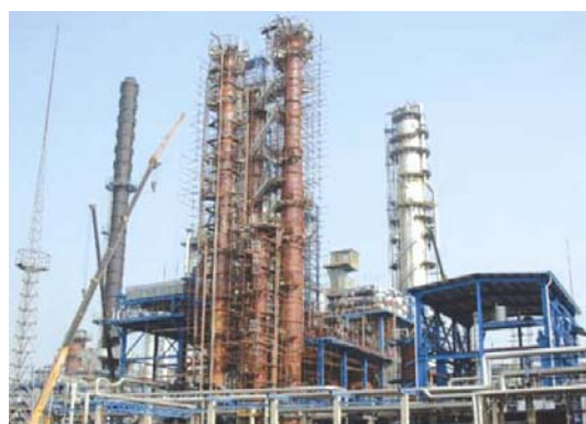
伊朗 SHAZARAK 炼油厂扩建钢结构项目
