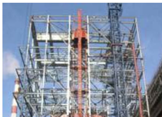
安徽铜陵电厂五期 1×300MW 锅炉钢架工程
