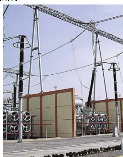
西北电网 750KV 官亭变电站钢结构
