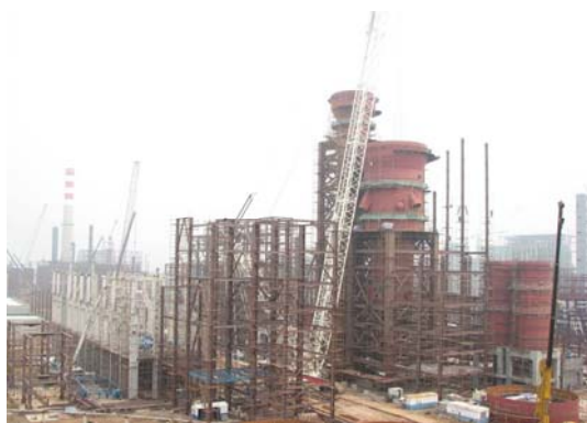
中石化青岛大炼油钢结构工程
