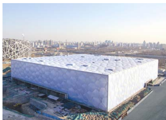
国家游泳中心“水立方”钢结构工程
