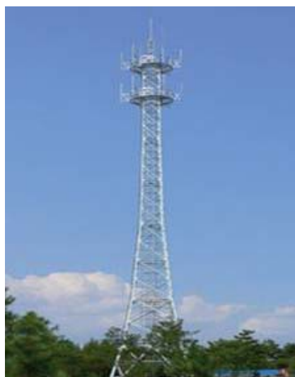
中国联通内蒙古公司通信角钢塔
