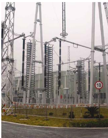
国家电网 500KV 湖北宜都换流站钢结构
