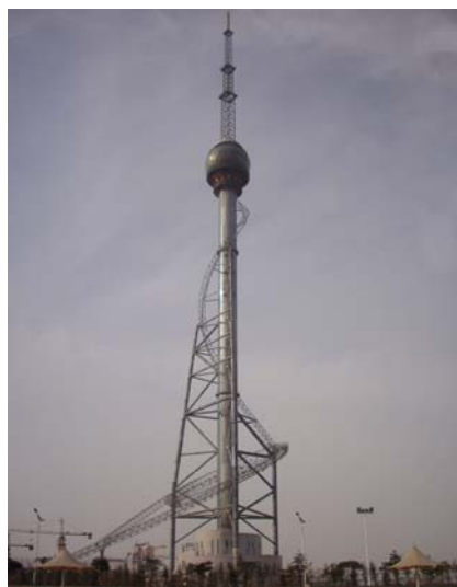
山东临沂广播电视发射塔钢结构工程
