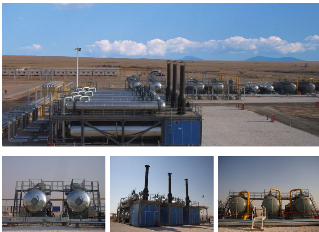
图：油田中心处理站油气处理系统
