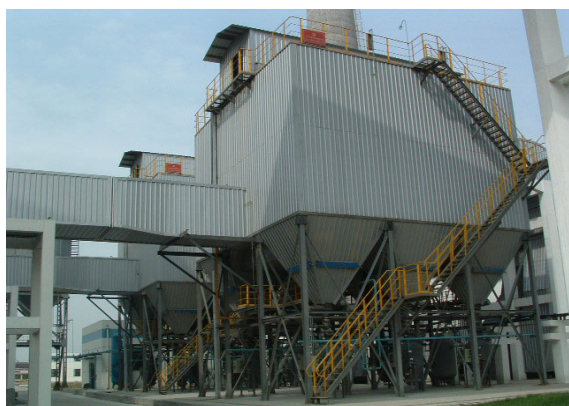
热电锅炉长袋脉冲除尘器 (电力行业, 无锡友联)
