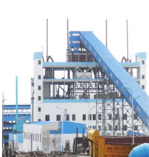
节能环保密闭矿热炉实景
