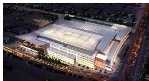
光伏建筑组件应用于沈阳恒隆广场
