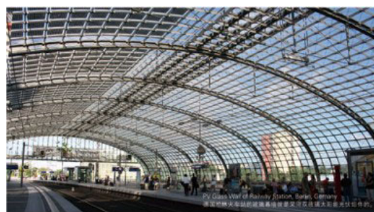
双玻璃光伏建筑组件应用于德国柏林火车站
