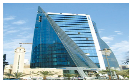
科威特 Warba 保险大楼双玻璃光伏遮阳棚
