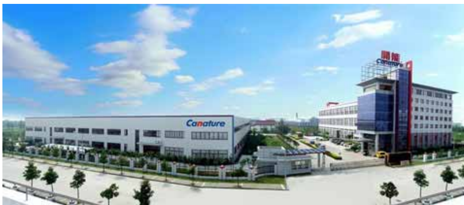
公司厂区全景图
