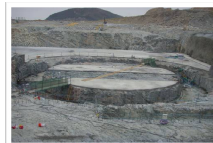
建设中的宁德核电站
