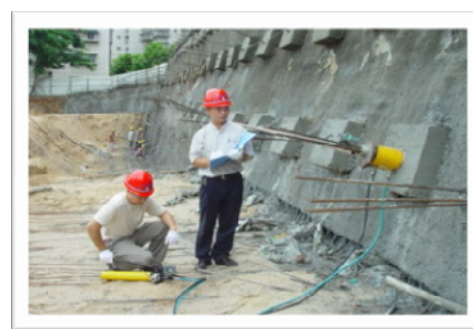
边坡支护工程 锚杆抗拔力试验
