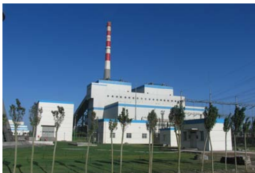
150MW 循环流化床锅炉
