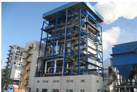
200MW 超高压中间再热燃煤锅炉
