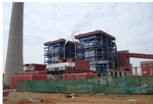
480t/h 循环流化床锅炉
