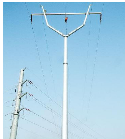
220KV 单回路酒杯型直线跨越塔
