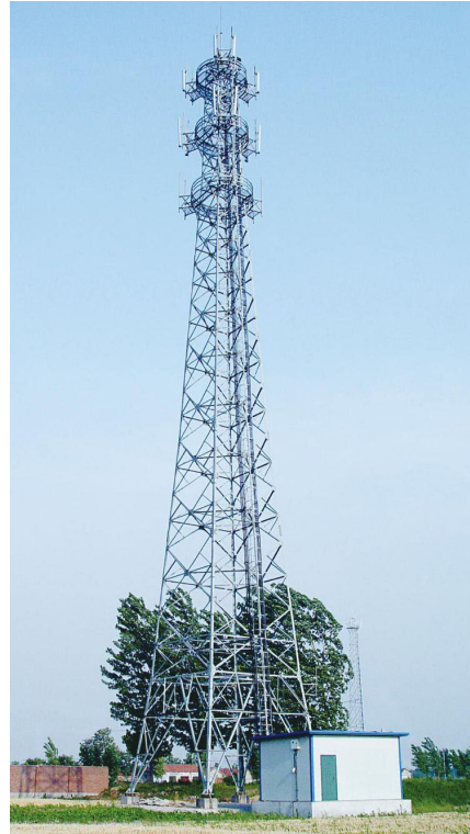
50 米微波通讯塔
