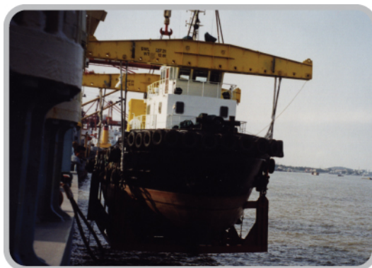
海洋特制梁式吊具吊装
