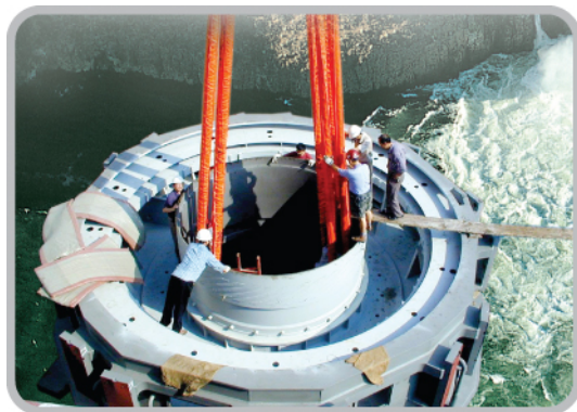
三峡工程 415 吨机组转子吊装
