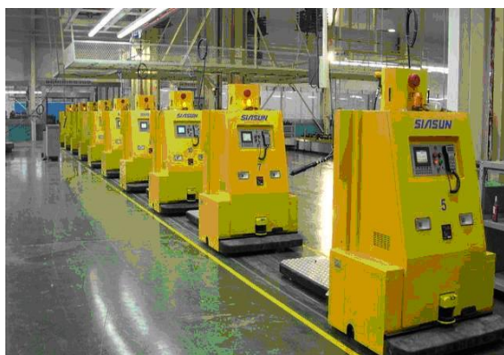
潍柴动力股份有限公司厂房总装2线AGV系统及配套设施
