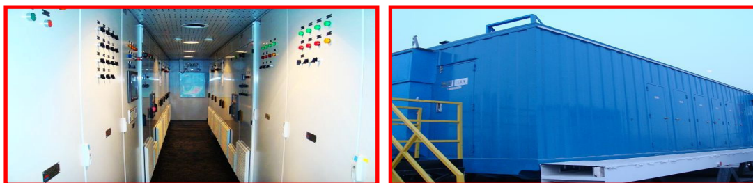
图：5000 米极地钻机变频一体化控制系统
