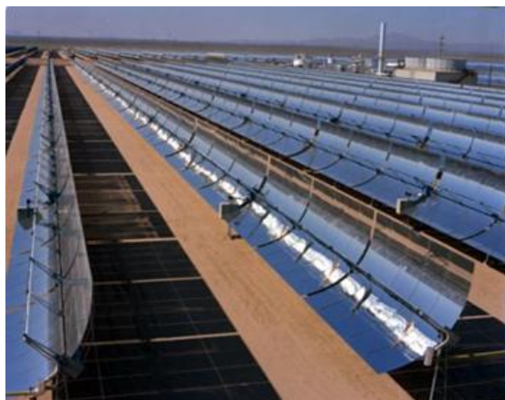
图 8：槽式光热发电站的聚光器
