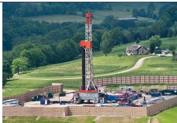
图 7：一口正在钻探的页岩气井
