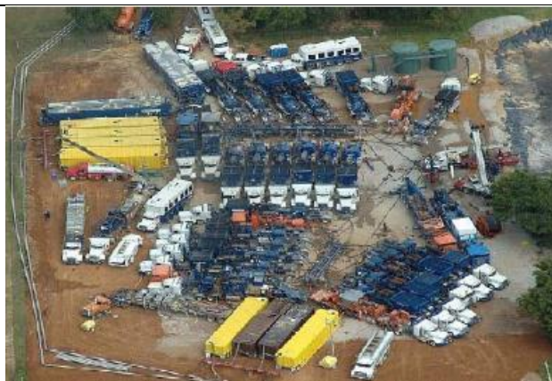
图 14: 页岩气水力压裂工程施工现场
