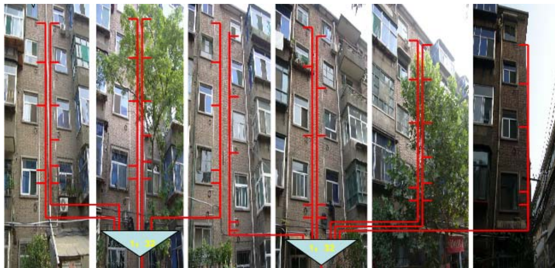
图 3: 老旧小区 FTTH 改造走线实例
