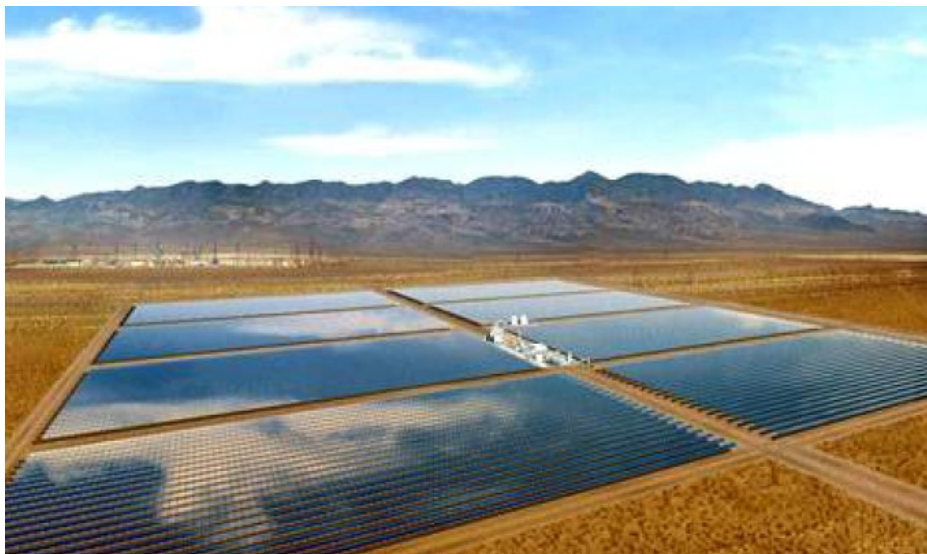
图表 14: Nevada Solar One 项目
