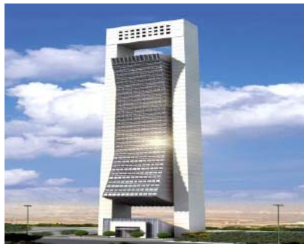
图 2：卡塔尔 AL-Faisal tower
