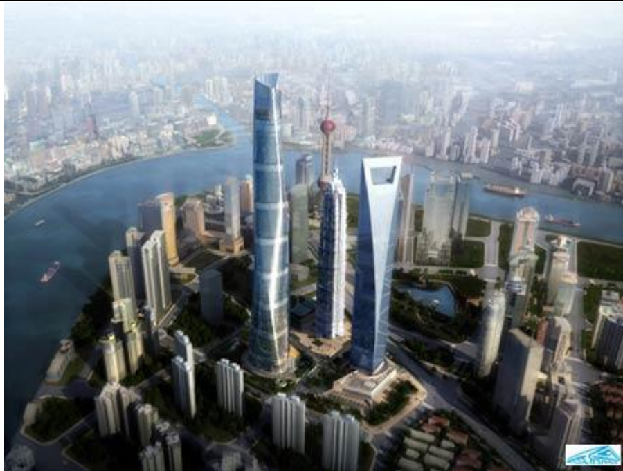
图 9、在建的上海中心将全部使用超白玻璃幕墙
