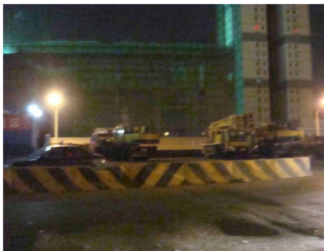
图 22：地铁 6 号线施工现场 1（5 月 13 日晚）
