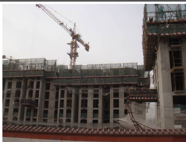
图 31: 燕山水泥厂地块项目 (5 月 11 日)
