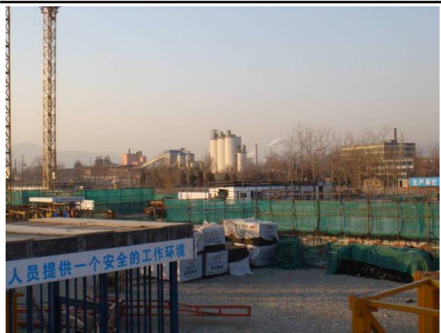
图 30: 燕山水泥厂地块项目 (1 月 12 日)
