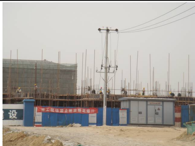
图 27: 上庄镇项目施工现场 (5 月 11 日)
