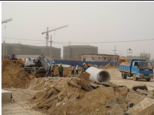
图 26: 上庄镇项目施工现场 (5 月 11 日)
