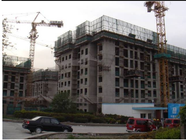
图 29: 燕山水泥厂地块项目 (5 月 11 日)
