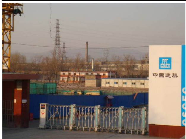
图 28: 燕山水泥厂地块项目 (1 月 12 日)
