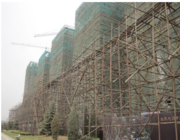
图 1： 金地仰山高板楼建设实景
