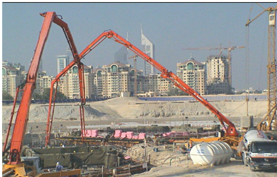
图表 33：三一 72 米臂架式混凝土泵车施工图
