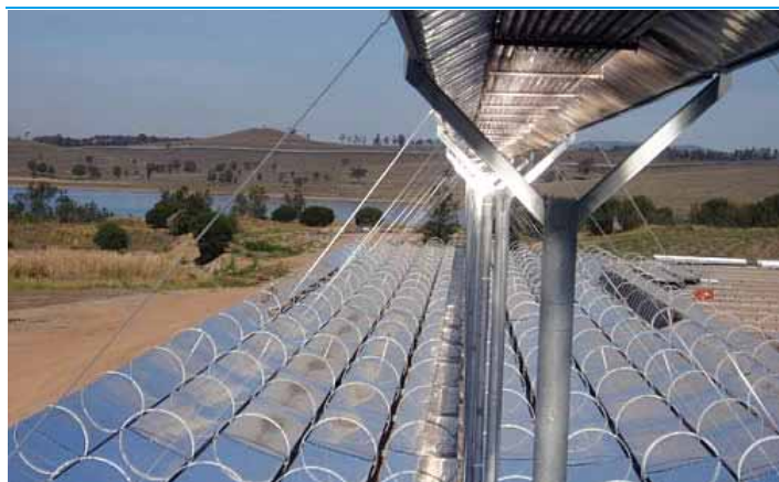
图表12：线性菲涅尔式 CSP 电站实景
