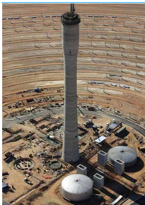
图表21：建设中的 Gemasolar 电站
