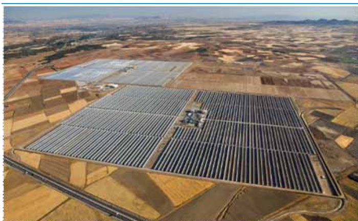
图表4：抛物面槽式 CSP 电站实景
