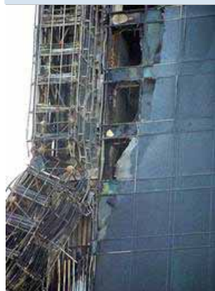
PS 板应用（央视裙楼）
