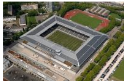
瑞士伯尼尔1MW光伏建筑一体化 51
