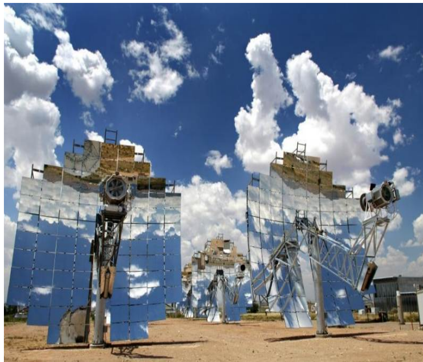
图21：碟式斯特林太阳能热发电系统单元
