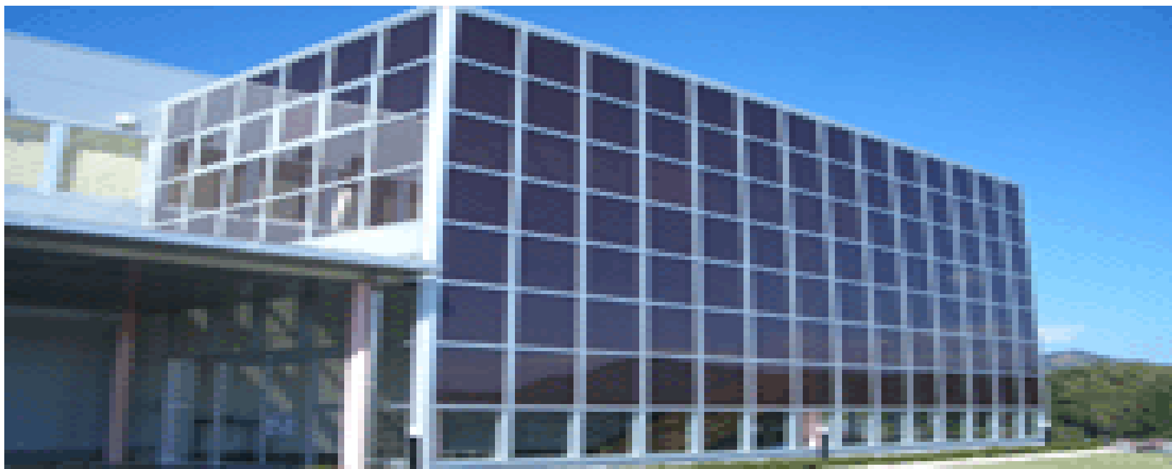
图、典型的光伏建筑一体化工程
