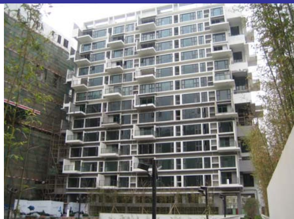
图 14、第五园五期高层住宅楼现场
