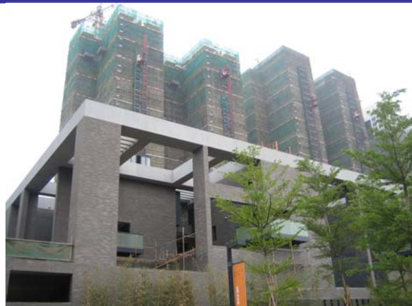
图 12、金城华府一期现场
