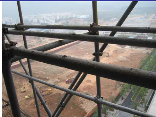
图 13、金城华府二期现场
