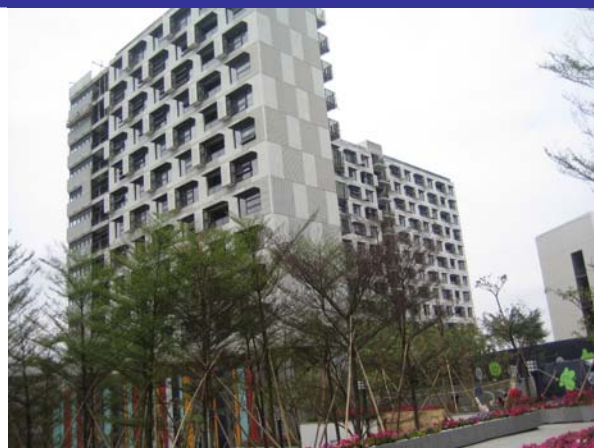
图 15、第五园五期公寓楼现场
