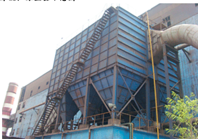
图 15：除尘器示意图
