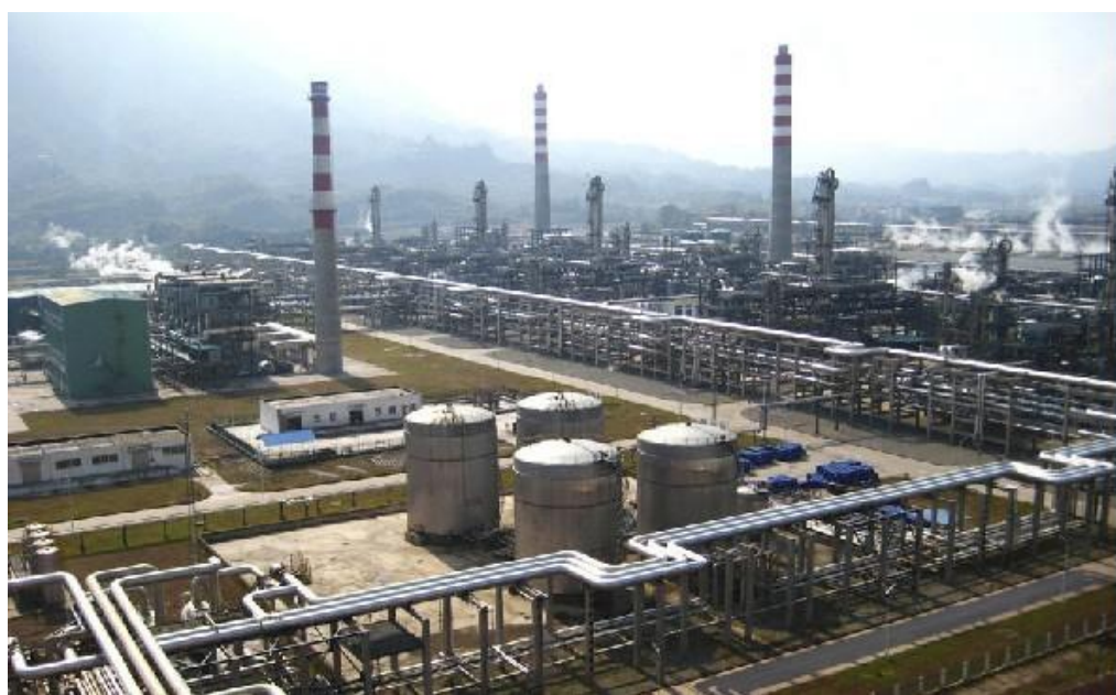
图 1.2 普光气田达州天然气净化厂
