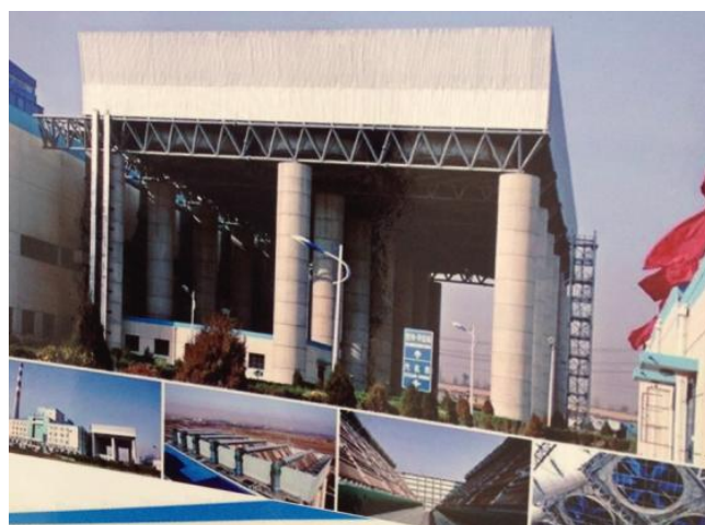
图 4：蓝科高新生产的大型板式电站式空冷设备，变革传统电站空冷
