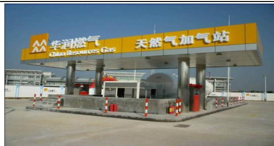
图 6：撬装式 LNG 加气站
