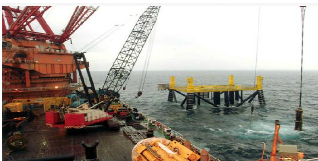
图 五：安装施工现场图
