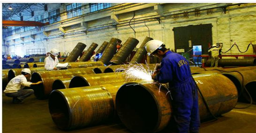
图 4: 公司工人焊接工作现场
