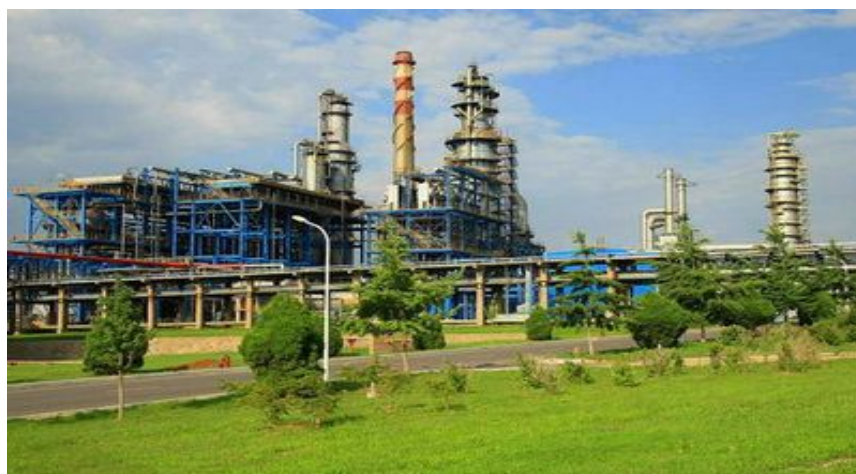
图 2.2 辽阳石化 550 万吨/年常减压装置
