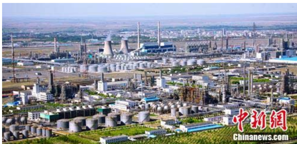
图 2.1 独山子石化公司厂区
