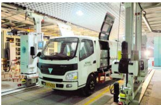
图表 45：北京航天桥充电站使用公司电池交换站产品
