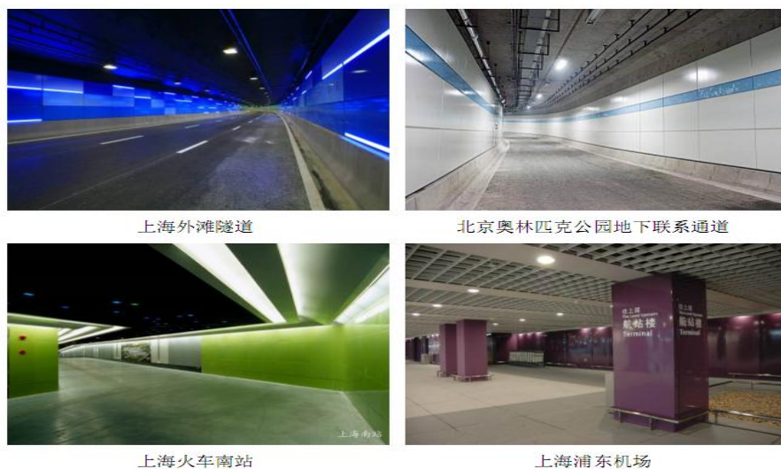
图3：建筑装饰用搪瓷钢板在其他地下空间中的应用
