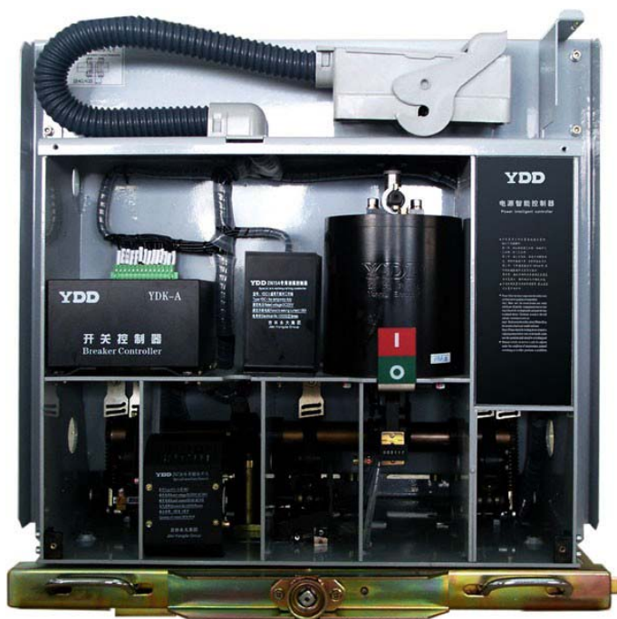
图 2：永磁开关内部结构
