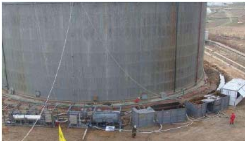
图 17: 储油罐清洗现场
