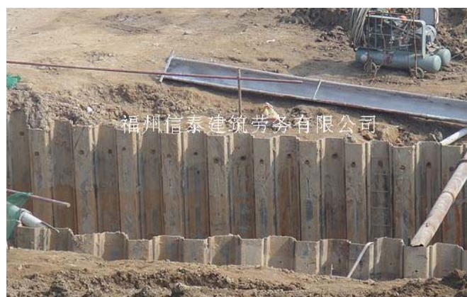
图 18：承插式管材在软基时需要使用钢板桩
