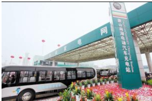
图 13 南瑞承建的唐山南湖电动汽车充电站
