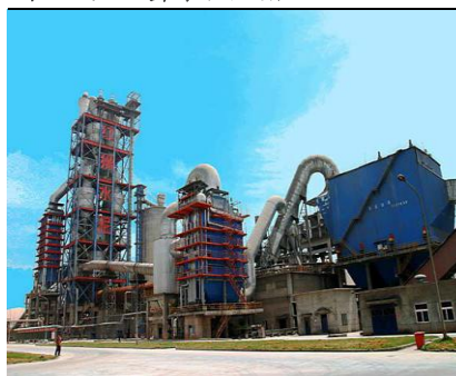
图 3 水泥窑余热锅炉
