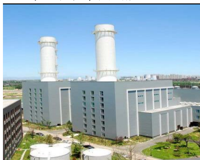
图 2 燃机余热锅炉
